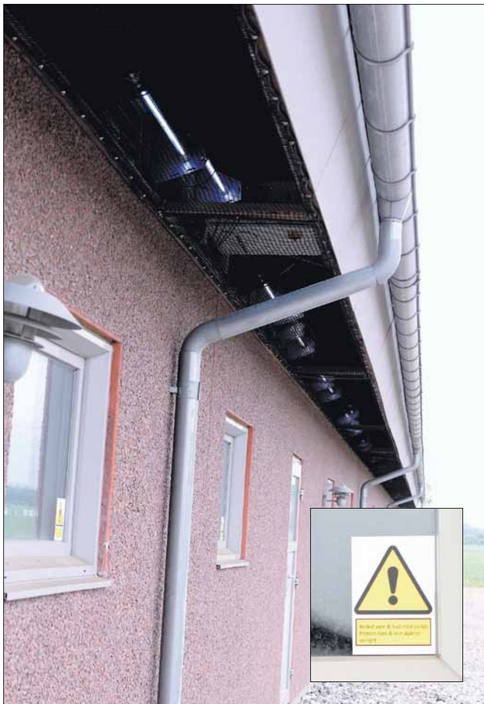
Man kan få »svejsøjne« ved at kikke direkte i UV-lyset, hvis man kommer tættere på end to meter. Derfor er der sat advarselsskilte op.
