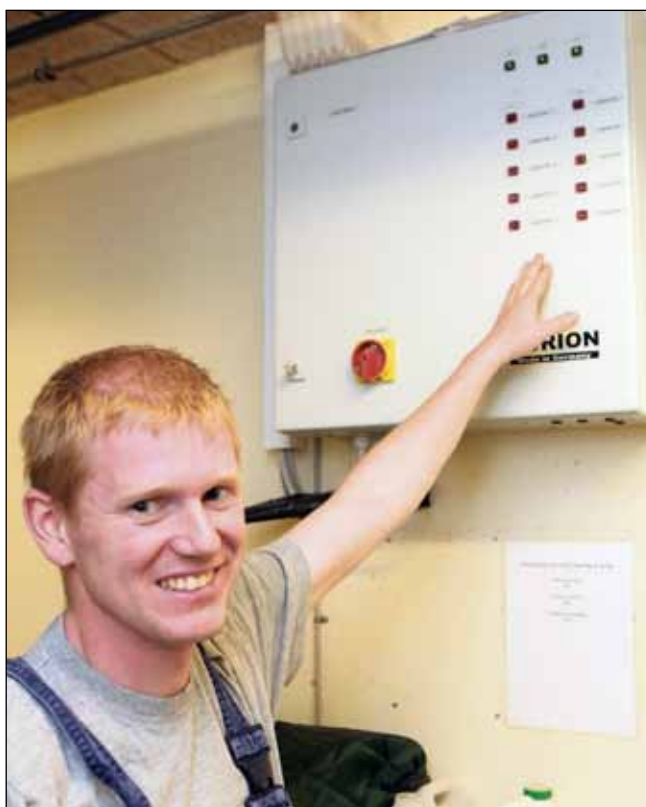
Et kontrolpanel holder øje med, om alle UV-lamperne rundt om stalden fungerer. UV-lamperne udenfor stalden er tilsluttet i grupper af seks. Jørgen Skou Hansen forklarer, at hvis en af UV-lamperne går ud, vil en rød advarsel lampe tilhørende den pågældende gruppe tænde på kontrolpanelet.
