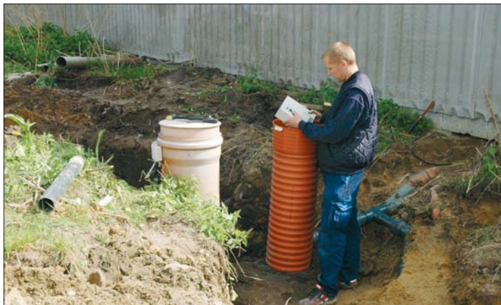
Til venstre ses brønden med demomodellen af UV-lyset, som Nicky Henriksen (på billedet) har udviklet og testet sammen med minkavlere Allan Gadeberg Jensen. I røret til højre er den nye lyskilde placeret. Efter montering skal lyskilden skiftes cirka en gang om året (Foto: Stine Pedersen).
